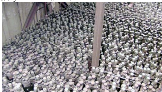
Рис. 1. Размещение ОТВС в осушенном бассейне выдержки
