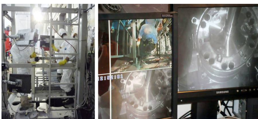
Рис.5. Выполнение работ по перетариванию ОЯТ на рабочей площадке
