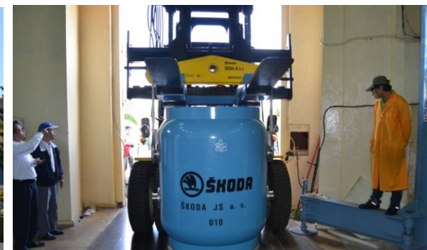
б – доставка контейнера SKODA VPVR/M в реакторный зал
