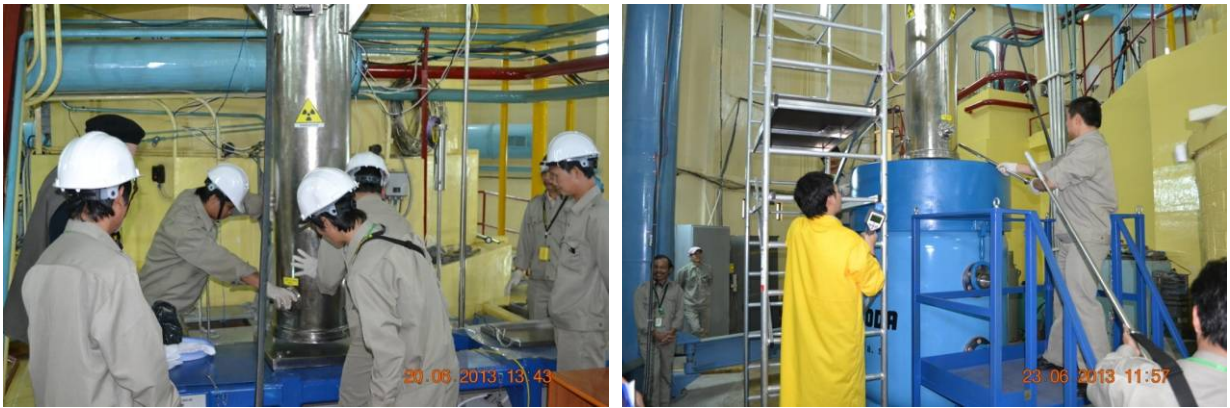
Рисунок 6. Выполнение практических работ по загрузке ОТВС ВВР-М2 в транспортный контейнер
