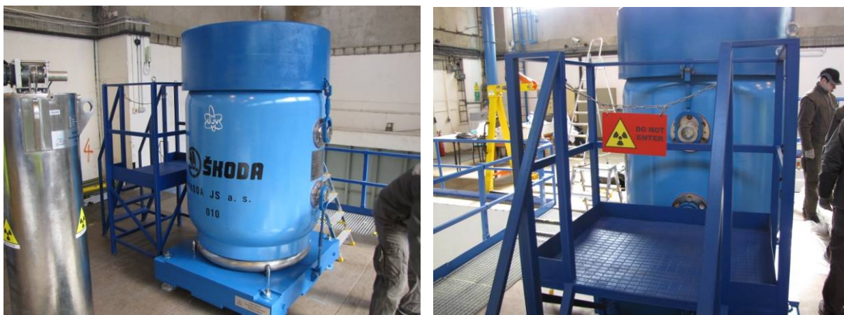
Рисунок 4. Выполнение монтажных работ в UJV
